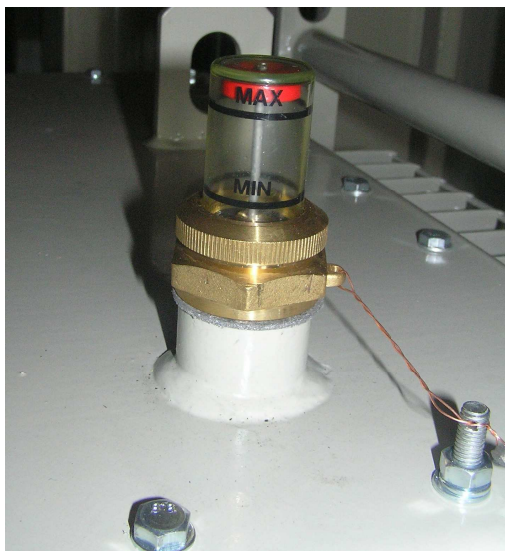
Рис. 7.1 Маслоуказатель поплавкового типа ILRM-1
